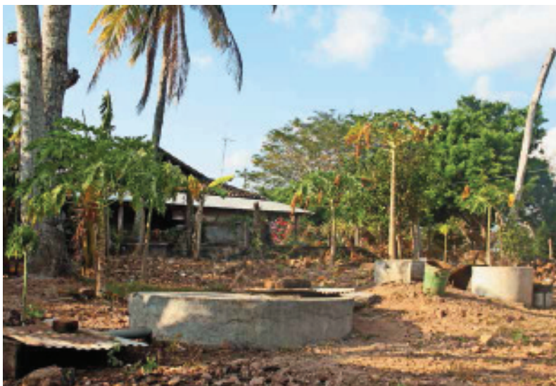
Die selbst gebaute Biogasanlage mit in der Erde vergrabenen Fermenter.
