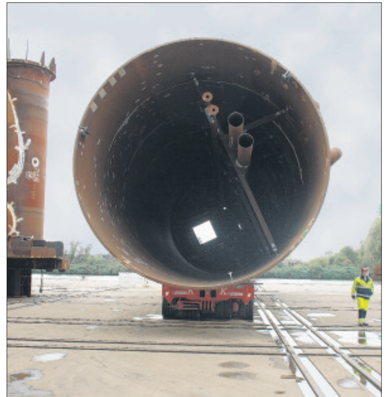
Stählerne Kolosse: Die Zentralrohre der Fundamente haben einen Durchmesser von 6 m. Sie werden in den Meeresboden gerammt. Fotos (3): Oliver Ristau
