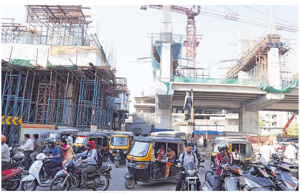
Und noch etwas ist besonders an dem Bauwerk. "Es ist das erste Mal, dass in Indien ein bis zu vier Ebenen umfassendes Transportsystem gebaut wird", sagt Ramnath – über der normalen Straße eine Trasse für eine neue Schnellstraße und darüber die Metro. Auf 8 km soll zusätzlich noch eine Ebene für die Regionalbahn integriert werden.
