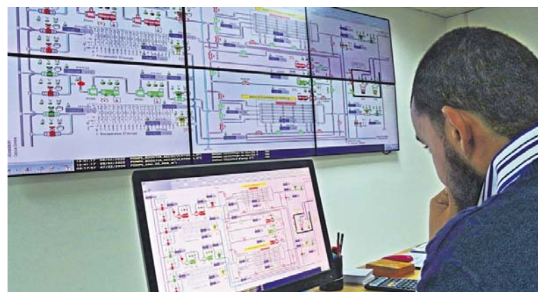
Im Kontrollraum werden Temperatur und Salzgehalt ständig überprüft. Die Grafiken auf den Monitoren zeigen dies in Echtzeit an. Foto: Oliver Ristau
