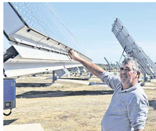
Alles geregelt: Sergio dos Santos ist stolz. „Das läuft alles automatisch“, erklärt er. Ein Algorithmus und ein Pyrheliometer, der die aktuelle solare Strahlung misst, sorgen dafür. Foto: Oliver Ristau
