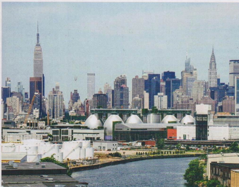
Silberne Gärbehälter am Newtown Creek: Das dort entstehende saubere Gas versorgt gerade mal 5000 Haushalte
