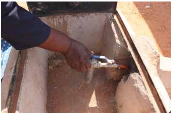
Über dem Fermenter befindet sich der Gashahn, den die Biogasbäuerin bei Bedarf aufdreht.
