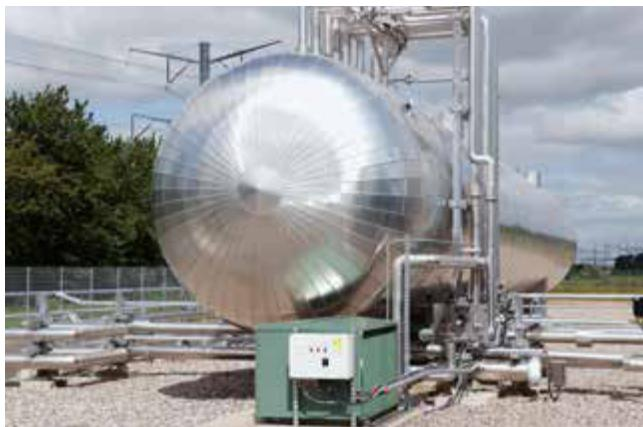
Das Kohlendioxid wird von einer benachbarten Biogasanlage gebracht. Es lagert in Tanks, bevor es auf 37 bar verdichtet und in die Synthesekammer gepumpt wird.
