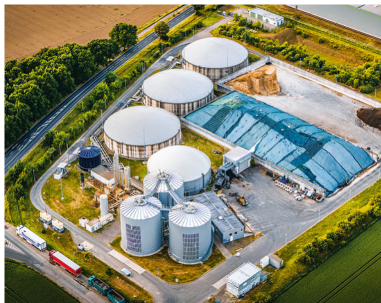
Biogasanlage: Bei der Veredelung zu Biomethan wird das CO 2 aus dem Biogas ausgeschieden und kann so den fossilen Rohstoff ersetzen
