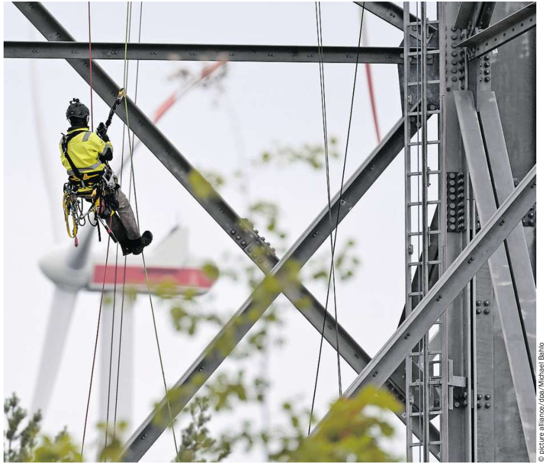
Gegenüber 2020 sind die Installationskosten für Landanlagen um 20 Prozent gestiegen.
